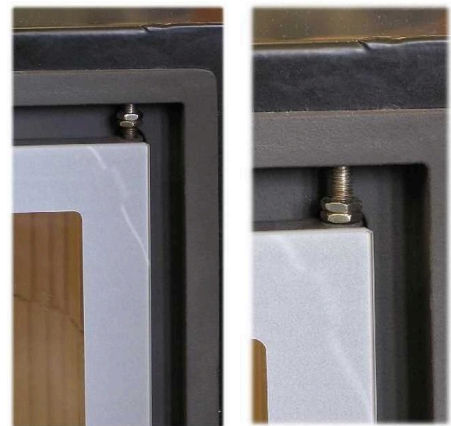
Im. 3: Loosening the door stop
